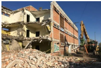
Quelle: DB Netz AG
