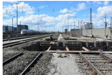
Quelle: DB Netz AG
