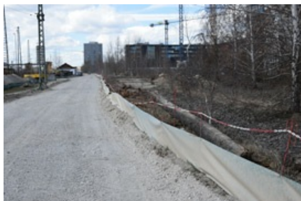
Quelle: DB Netz AG
